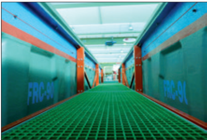
Tramex gangway in FRP
