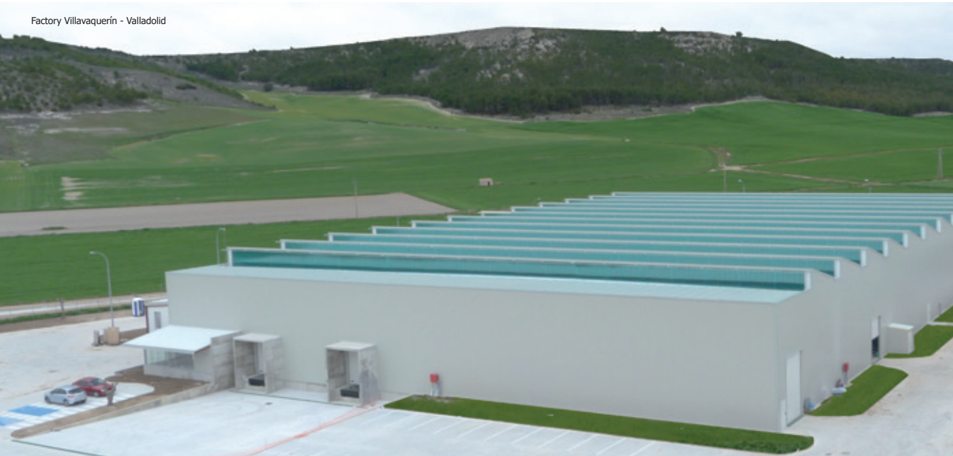
Factory La Cistèrniga - Valladolid
